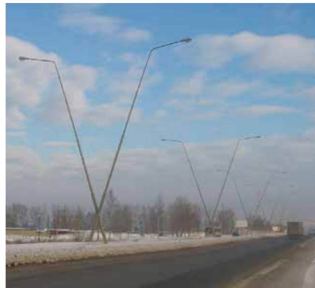
г. Москва, трасса в аэропорт
