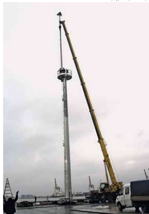
Монтаж мачты МГФ-СР-М, г. Санкт-Петербург, Морской порт
